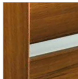
połączenie ramiaka, paneli i szyby
