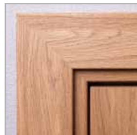
standardowe łączenie opasek pod kątem 45°
